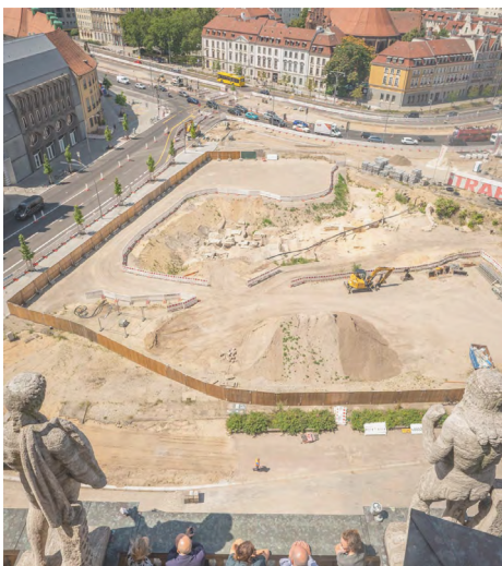
Blick vom alten Stadthaus auf ein Baufeld
